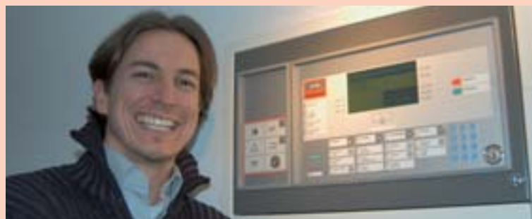
Bauchef Othmar X. Freitag mit der neuen Brandmeldeanlage.
