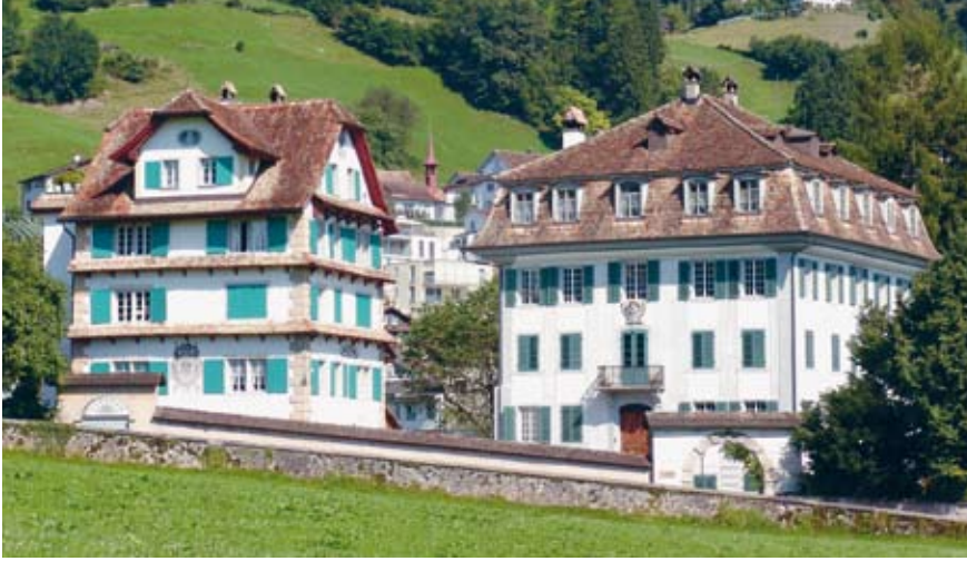
Die beiden Hettlinger-Häuser stehen für zwei verschiedene Epochen. Das sogenannte Steistöckli vertritt die Nachfolge des mittelalterlichen Wohnturms, das Palais mit dem Mansarddach gehört zu den spätesten Vertretern des Herrenhauses.
