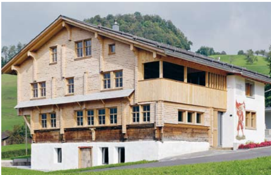
Das Köpli-Haus im Engiberg aus der Mitte des 16. Jahrhunderts gehört zu den Bauten am Übergang vom mittelalterlichen Holzbau zum steinernen Herrenhaus des 17. Jahrhunderts. Die bergseitige Hausteil ist gemauert, die talseitige als Strickbau ausgeführt.
